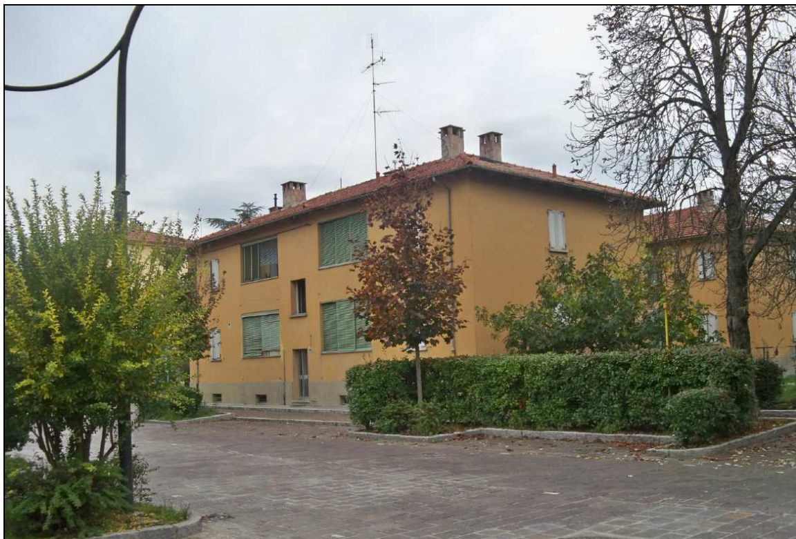
Edifici ERP lungo via Roma
