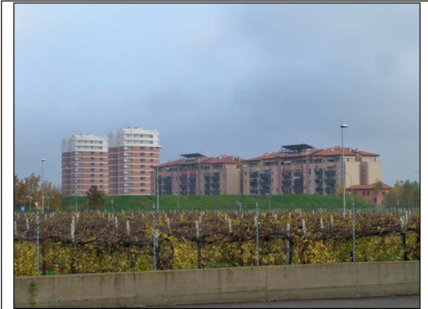
Panoramica condomini Comparto 141
