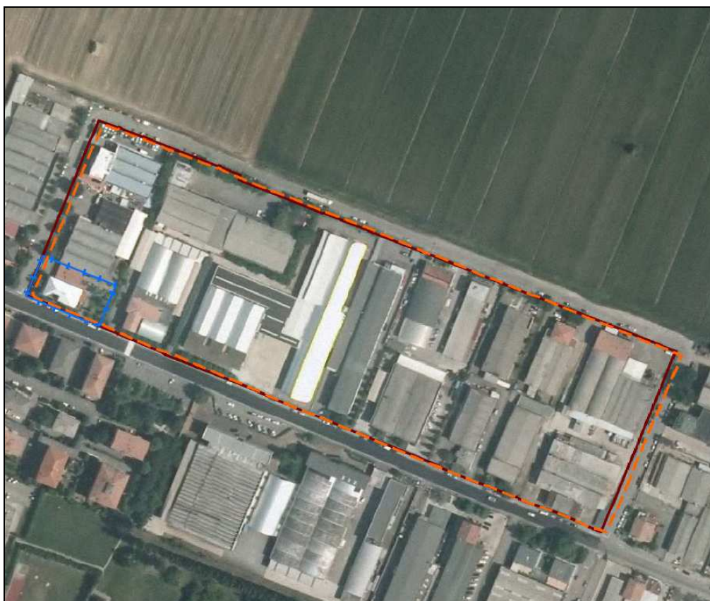
Ambito di riqualificazione di via Armaroli inserito in POC (in arancione il perimetro dell'ARS del PSC, in blu il perimetro inserito in POC)- Scheda 'Armaroli 1'
