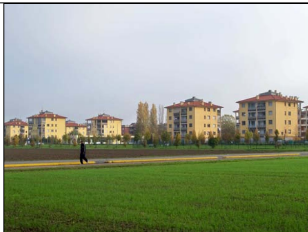
Panoramica condomini Comparto 111
