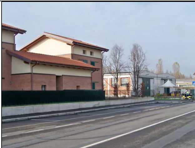
Via Armaroli – Villette e capannoni artigianali
