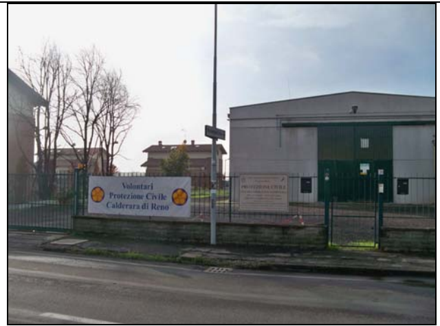
Via Armaroli – Villette e capannoni artigianali
