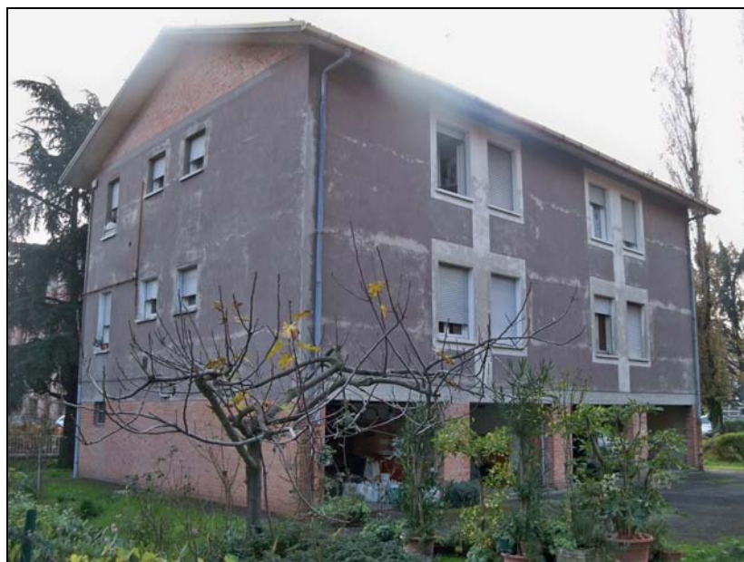
Edificio ERP incrocio via Roma - via Turati
