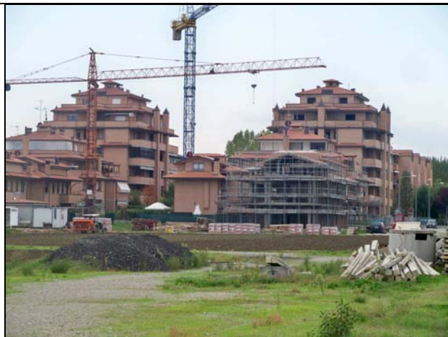
Edifici nuovi ed in cantiere comparto 107
